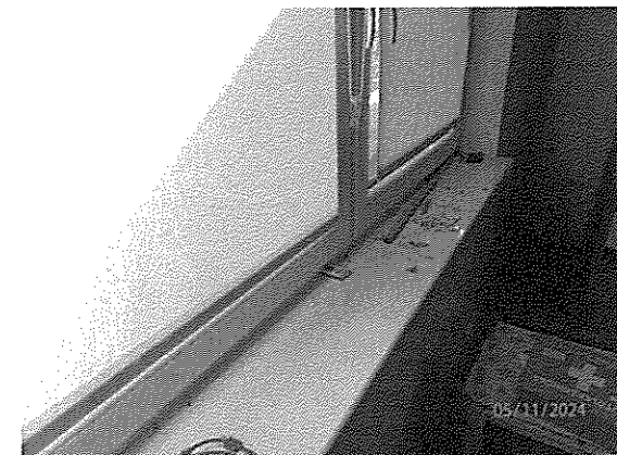
Detail okna strednej izby
