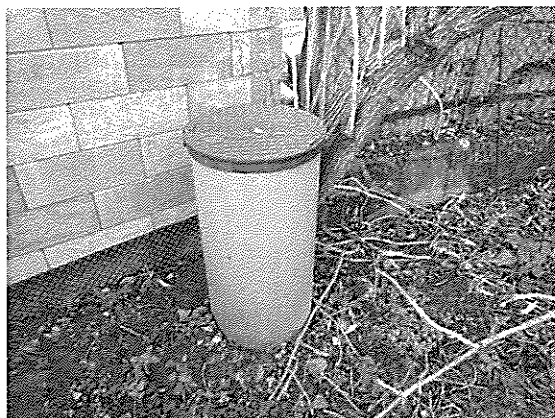
Nová kanalizačná šachta vo dvore
