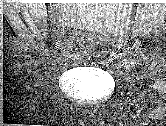
Nová vodomerná šachta vo dvore
