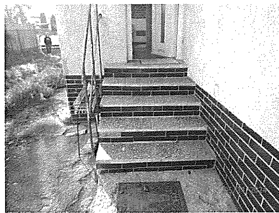
Schody z dvora do zadnej verandy
