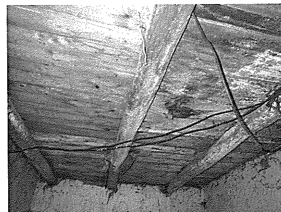
Strop skladu hospodárskej časti domu
