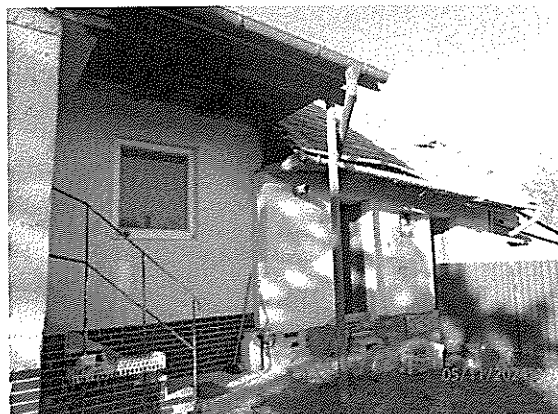
Zadná časť domu z dvora
