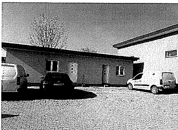
Skladové hospod. a šatne na p.č. 286/19 - pohľad V
