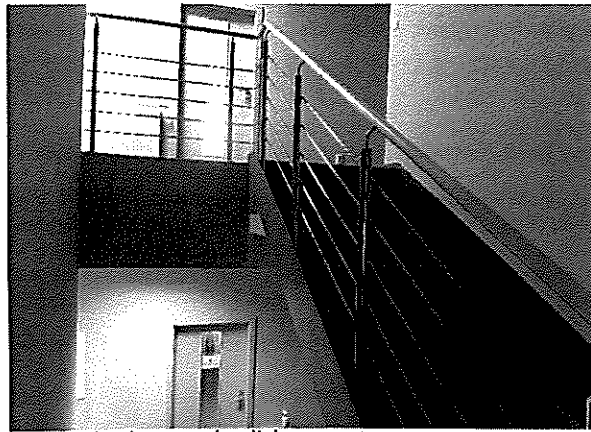
Adm. budova - schodisko
