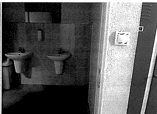
Adm. budova - WC v 1. NP
