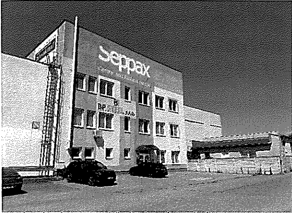
Adm. budova - pohľad juhovýchodný
