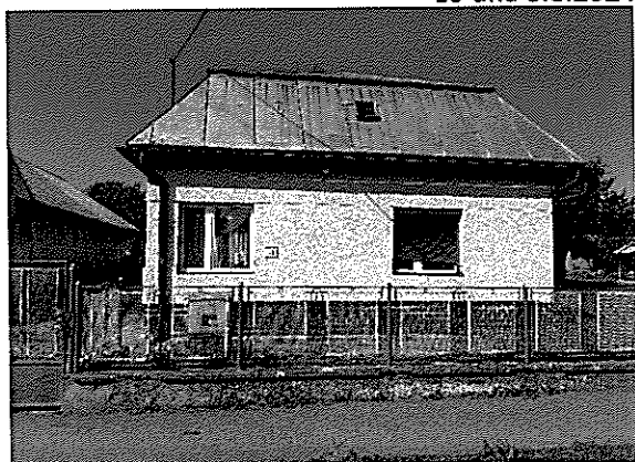
Pohľad na dom východný
