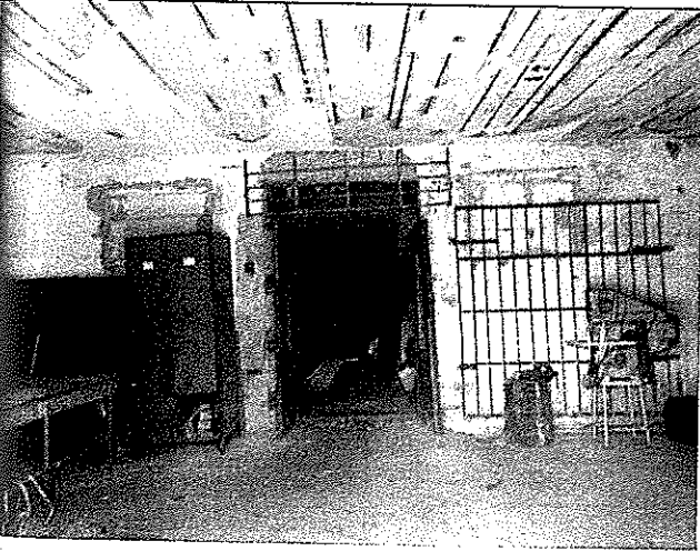
Interiér Hospodárskej budovy s.č.181
