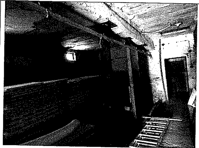
Interiér Hospodárskej budovy s.č.181
