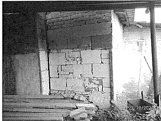
Hospodárska budova za domom
