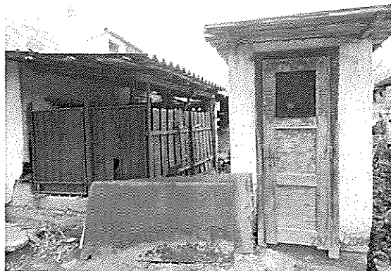
Hospodárska budova za domom
