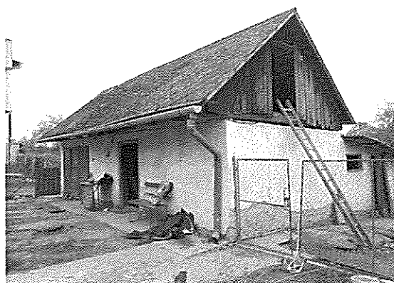
Hospodárska budova za domom
