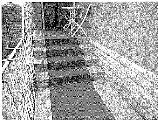
Vonkajšie schody do domu od ulice
