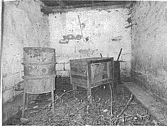
Hospodárska budova za domom
