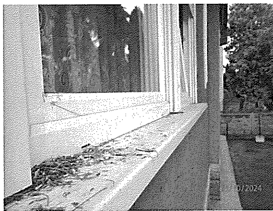
Detail okna od ulice z vonkajšej strany
