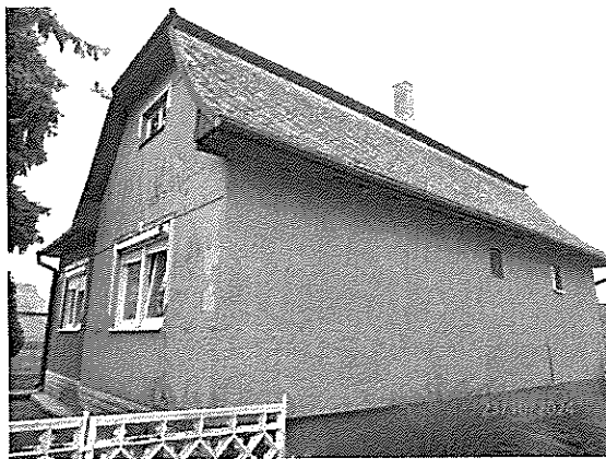
Západná strana domu
