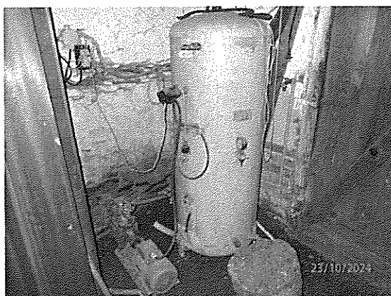
Nefunkčná domáca vodáreň v suteréne
