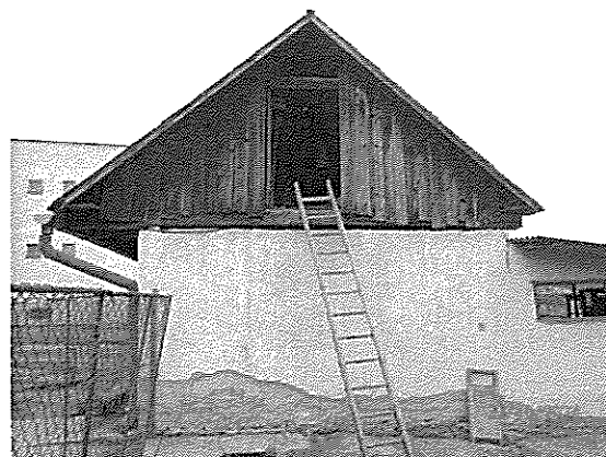
Hospodárska budova za domom
