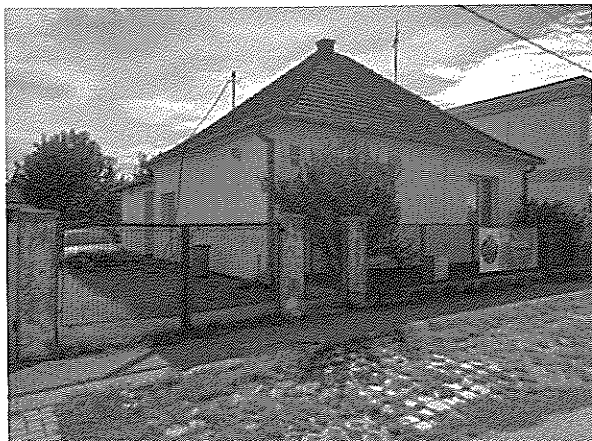
Pohľad od ulice
