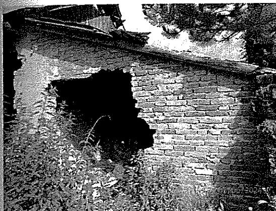
Dreváreň za domom na parc. 382/3
