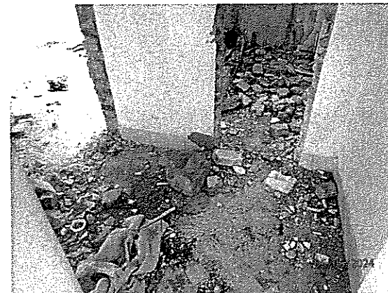
Chodba do kúpeľne a do izby na II.NP
