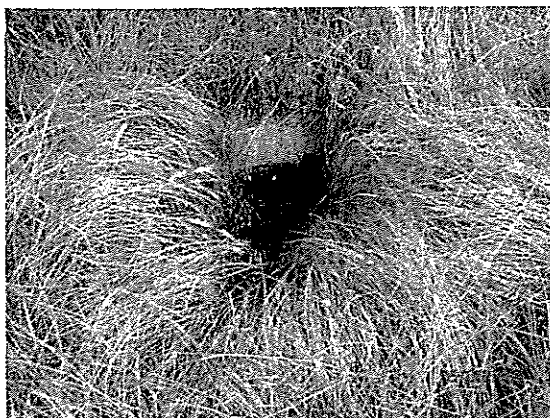
Vodomerňá šachta pred domom
