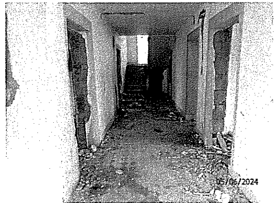
Chodba na I.NP
