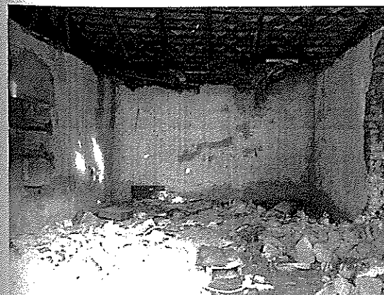
Pohľad do garáže na parc. 382/3
