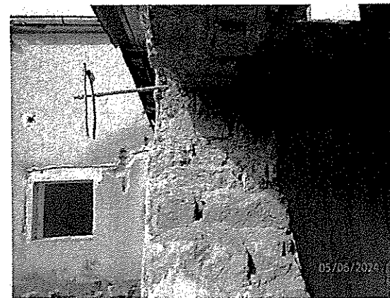
Obvodové murivo garáže na parc. 382/3
