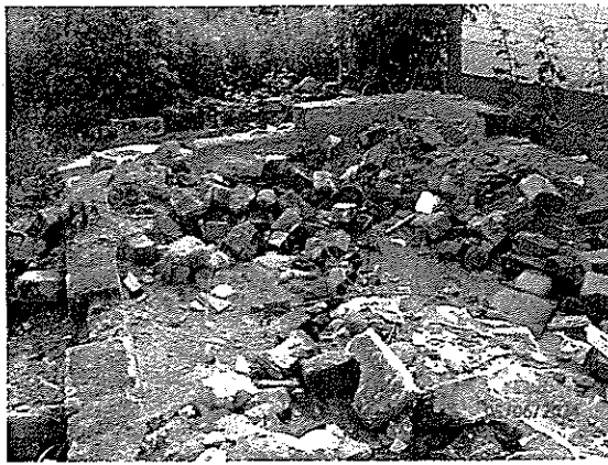
Zbúranisko po garáži na parc. 382/4
