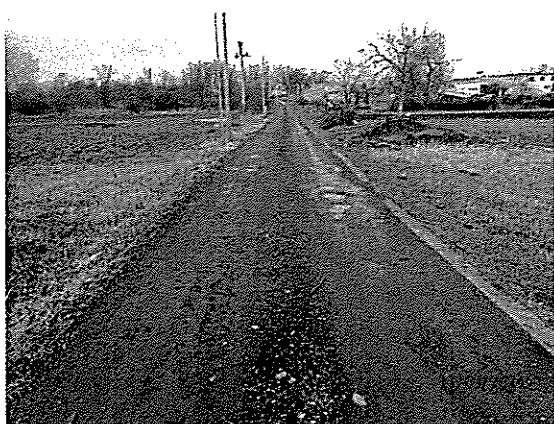
Prístupová komunikácia k domu na sever
