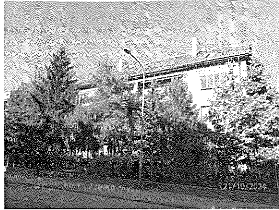
Pohľad na bytový dom z južnej strany
