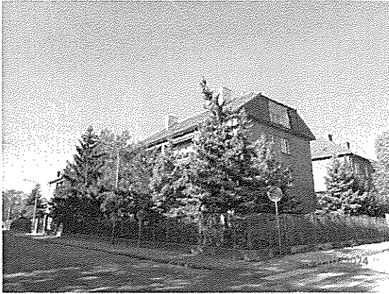
Pohľad na bytový dom z JV strany
