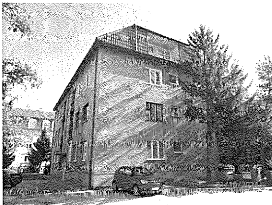
Pohľad na dom z dvora zo západnej strany
