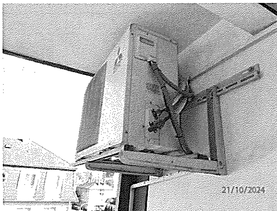
Vonkajšia jednotka klimatizácie
