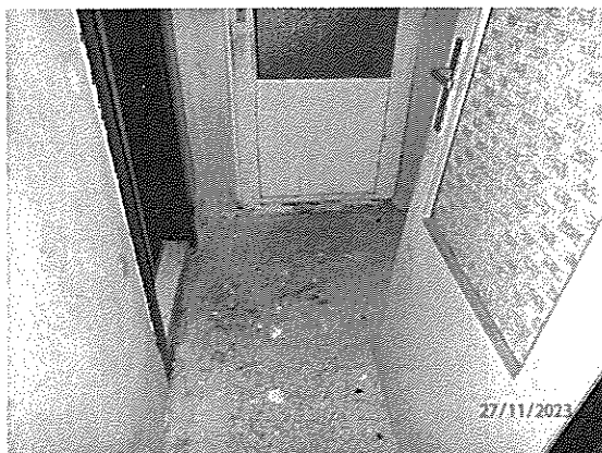
Prechod z kuchyne do komory a do izby
