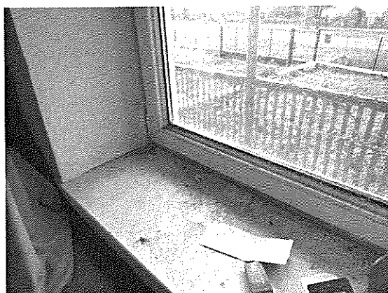
Plastové okno prednej izby od ulice
